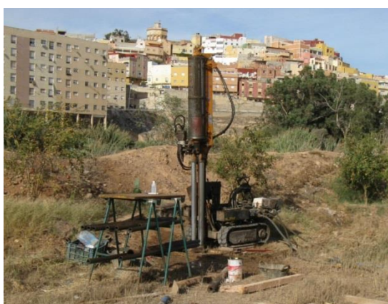
Foto 1: Equipo de perforación emplazado
