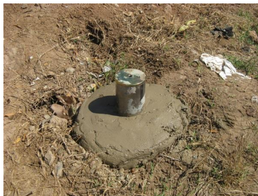
Foto 2: Acondicionamiento de los sondeos con tubo de PVC y cierre metálico
